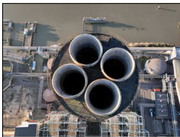
Photo de l'aire © EDF
